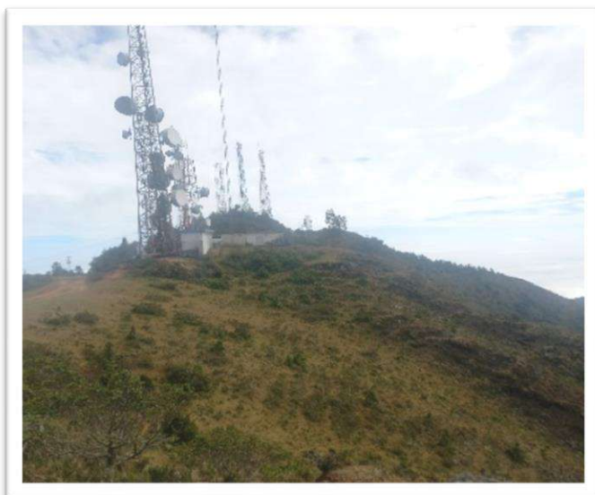
Figura 11. Ubicación de antenas en el cerro Guachaurco
